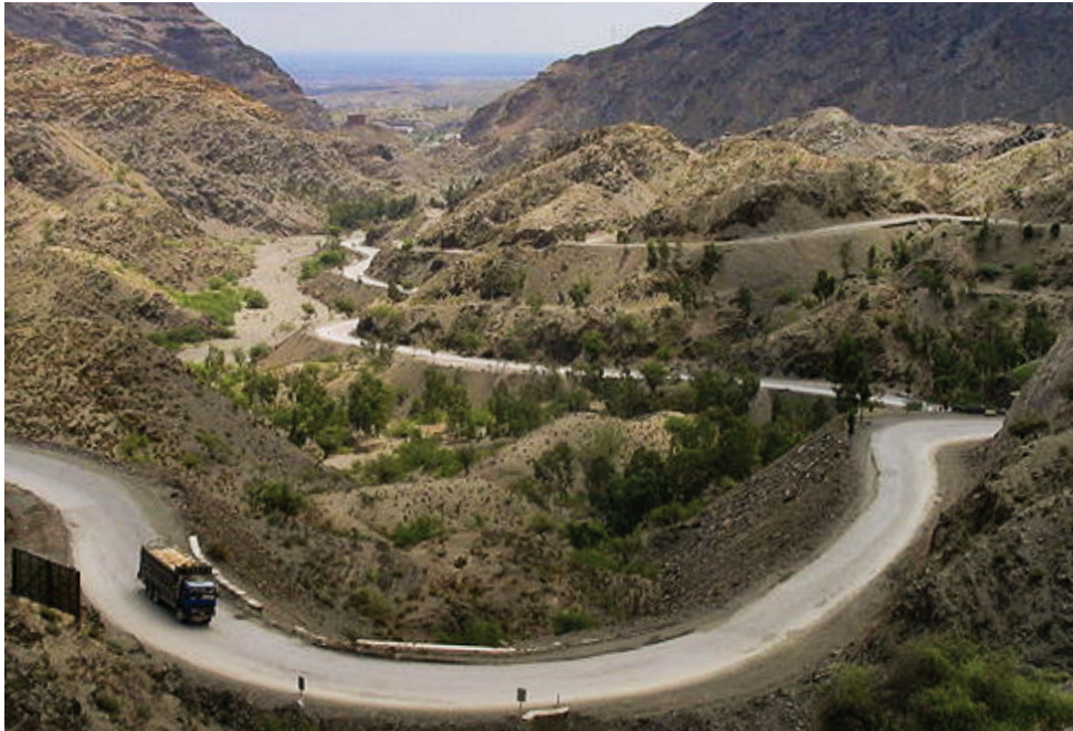
Fahrbahnwechsel am Khaiberpass
